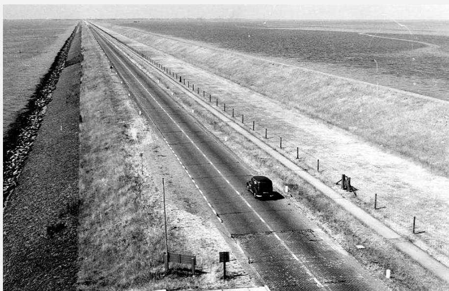
De Afsluitdijk met de binnenberm bestemd voor de spoorlijn.
